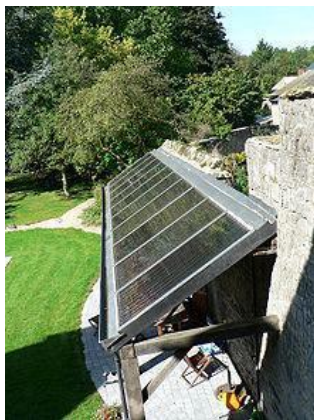
Colectoare solare pentru încălzirea apei din piscină.
