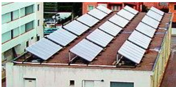
Colectoare solare pentru încălzirea apei din piscină.
